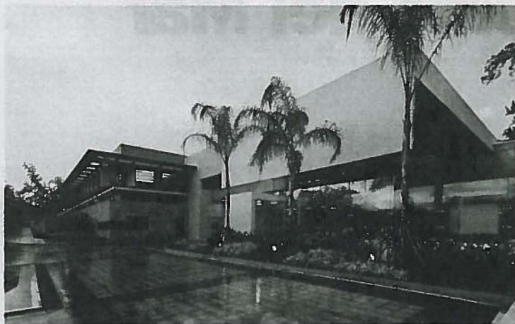
EN LA CATEGORÍA DE OBRA CONSTRUIDA EL PREMIO DE HONOR recayó en la Biblioteca del Tribunal Supremo de Puerto Rico, obra del Arq. Segundo Cardona, con la colaboración de la Arq. Carmen R. Fortuño y Arq. Ent. Luis Yordán.
